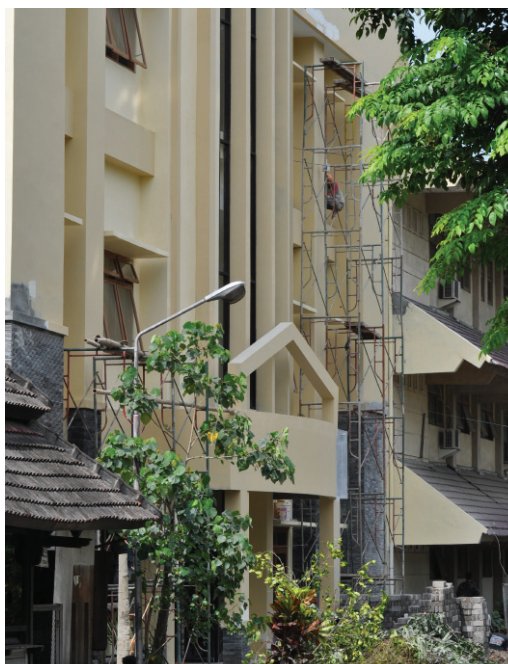
Pembangunan tambahan gedung laboratorium FMIPA. Saat ini UNY sedang menyelesaikan pembangunan gedung tambahan rektorat, gedung kuliah FBS dan FMIPA, serta tribun lapangan sepak bola dan lintasan atletik UNY.
