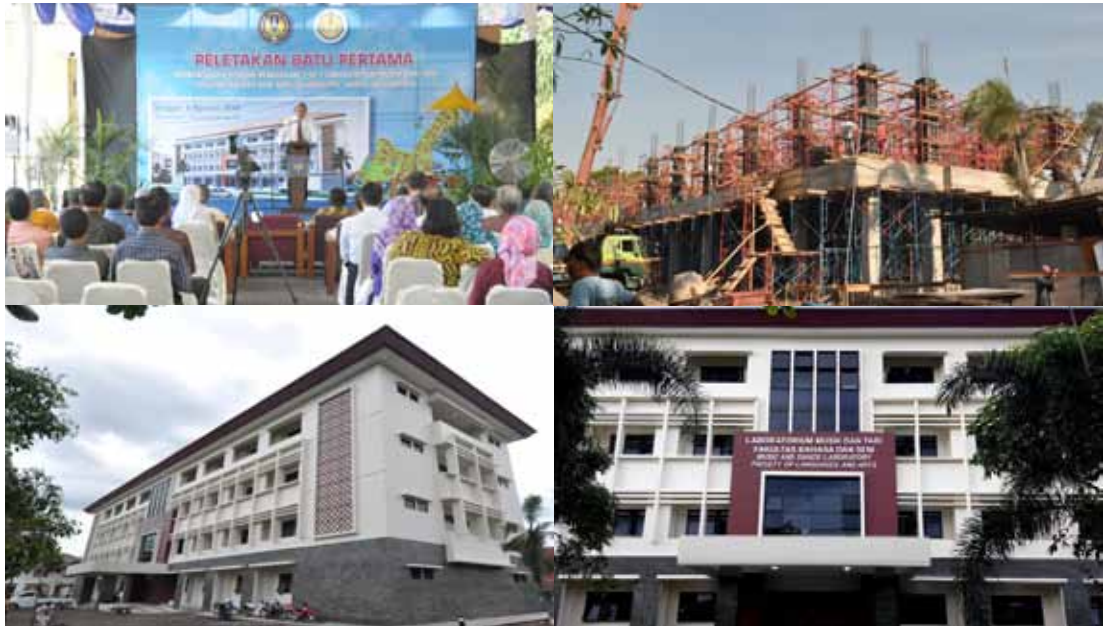
Tahap pembangunan Gedung Pendidikan 7 in 1 IDB Laboratorium Musik dan Tari FBS UNY dari Peletakan batu pertama hingga finishing.
