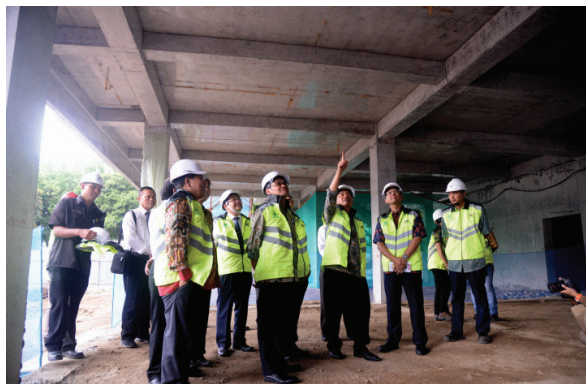
Gambar 3.23 Monitoring Pembangunan Gedung PPs
