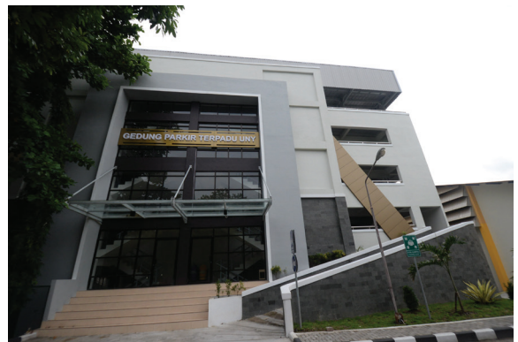
Gambar 3.26 Gedung Parkir Terpadu
