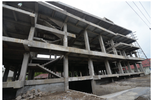
Gambar 3.27 Pembangunan Gedung IKA UNY
