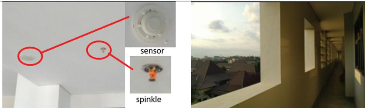
**Gambar 3.44 Sensor asap dan balkon dengan sirkulasi udara**
